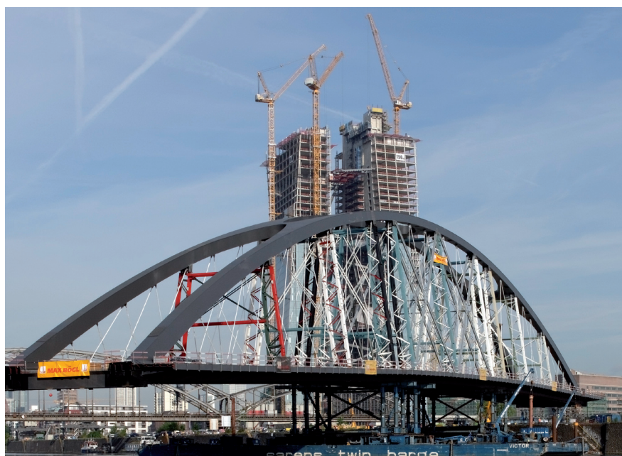
Neue Osthafenbrücke in Frankfurt am Main
